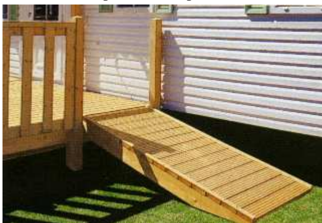
Rampe d'accès côté
