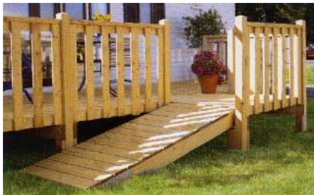
Rampes d'accès façade
